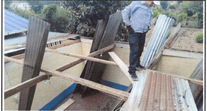
Foto 4: Mejorando techo de aula.
