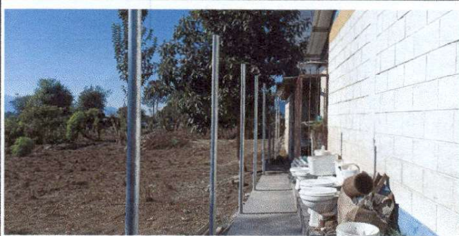
Foto 3: Restauración de muro perimetral.
