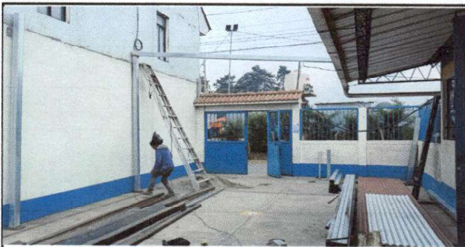
Foto 5: Trabajando estructura de techado.
